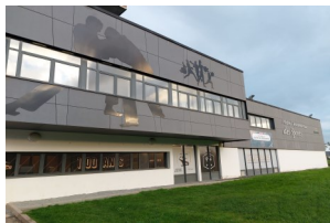
Maison Départementales des Sports à Bazeilles
